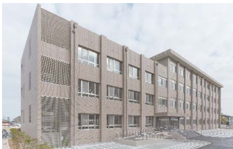
省エネを踏まえた改修建物 (H29年度 教養教育2号館)
